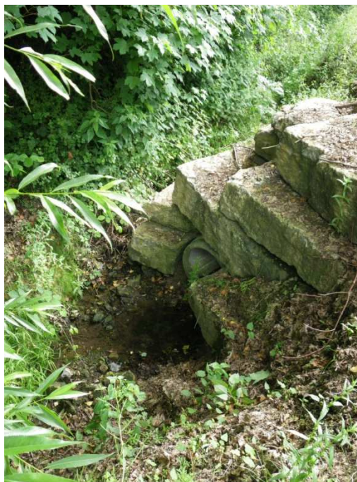
Figure 53 : rejet de la station d'Huslonniaux
