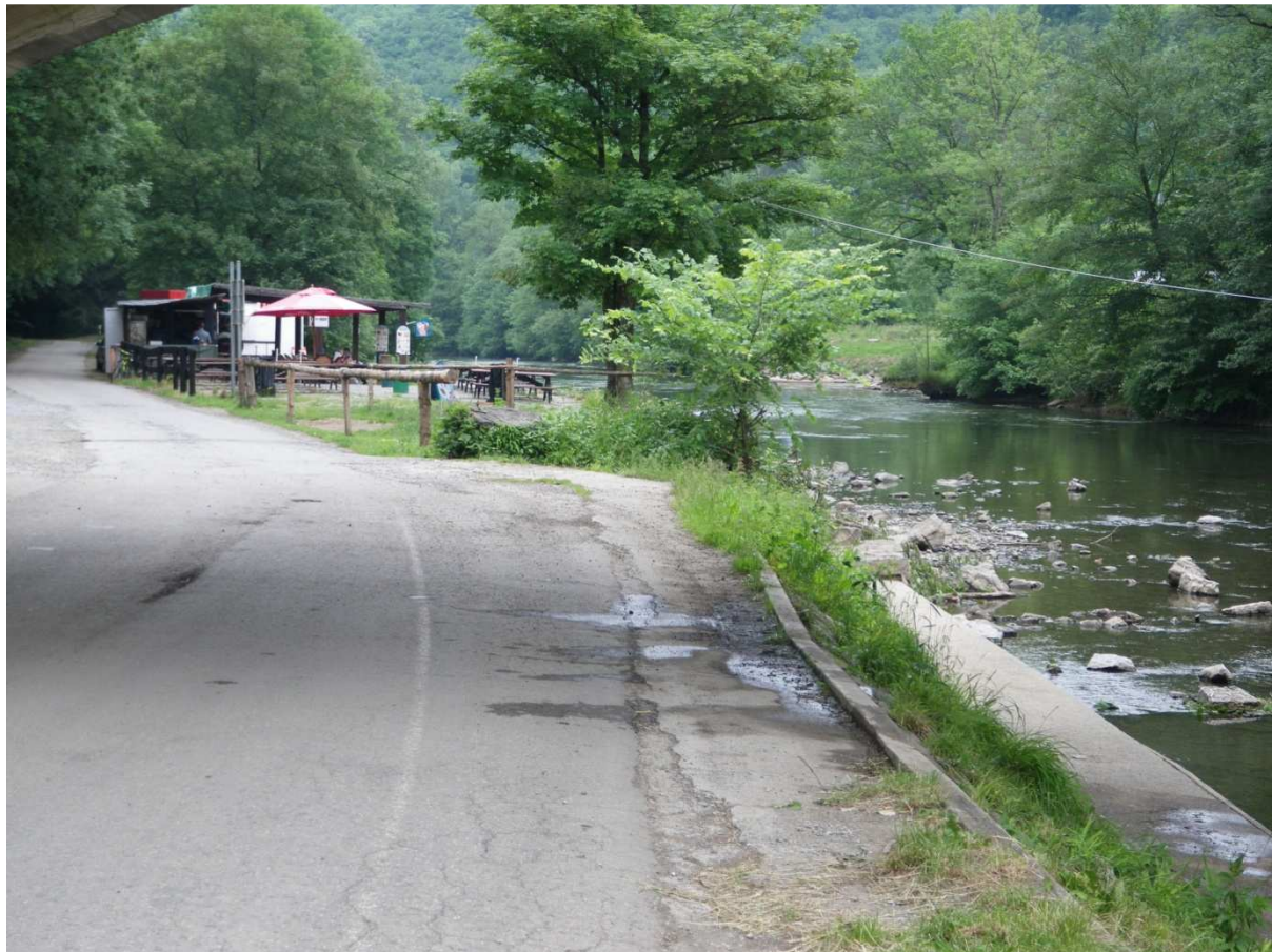
Figure 48: infrastructure présente à proximité de la zone de baignade I15
