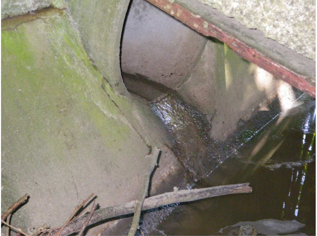
Figure 55: Déversoir d'orage de Gendron
